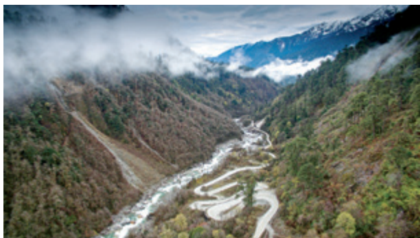
▲ 西藏墨脱公路
